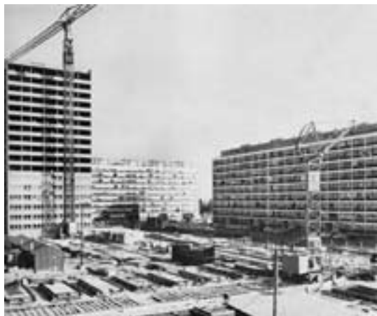
Naselje Utrina - proizvodnja i montaža stambenog tornja
